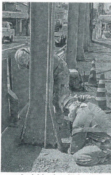
コンクリートに埋まった鋼材の点検をする作業員 (舞鶴市浜・万代橋)
