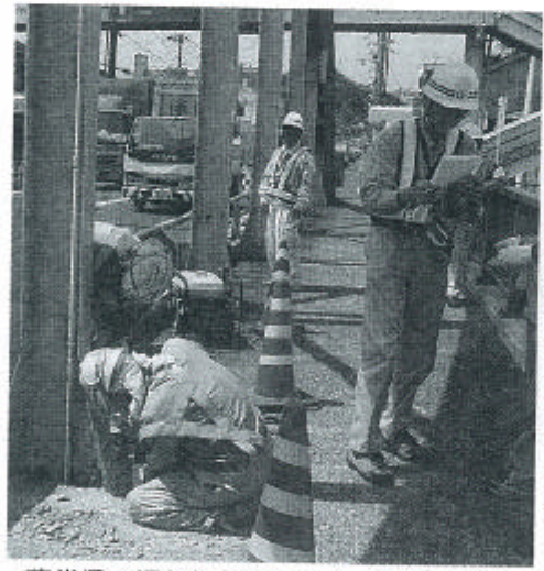
万代橋で行われた緊急点検 (舞鶴市で)
